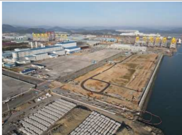
그림1 포스코필라리튬솔루션 광양 공장 건설중
